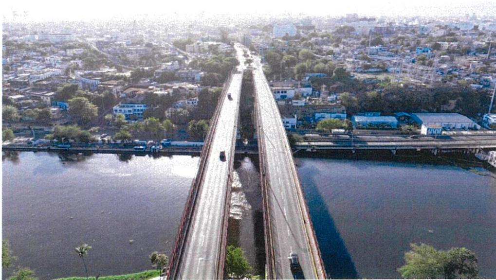
Con el propósito de mantener la consonancia arquitectónica y de diseño, en el tramo del cruce del Río Ozama, el viaducto del Monorriel estará sustentado en un tablero metálico con rigidizadores, como un “puente gemelo” al Puente Mella, empleando las mismas luces y apoyos en la parte norte.
