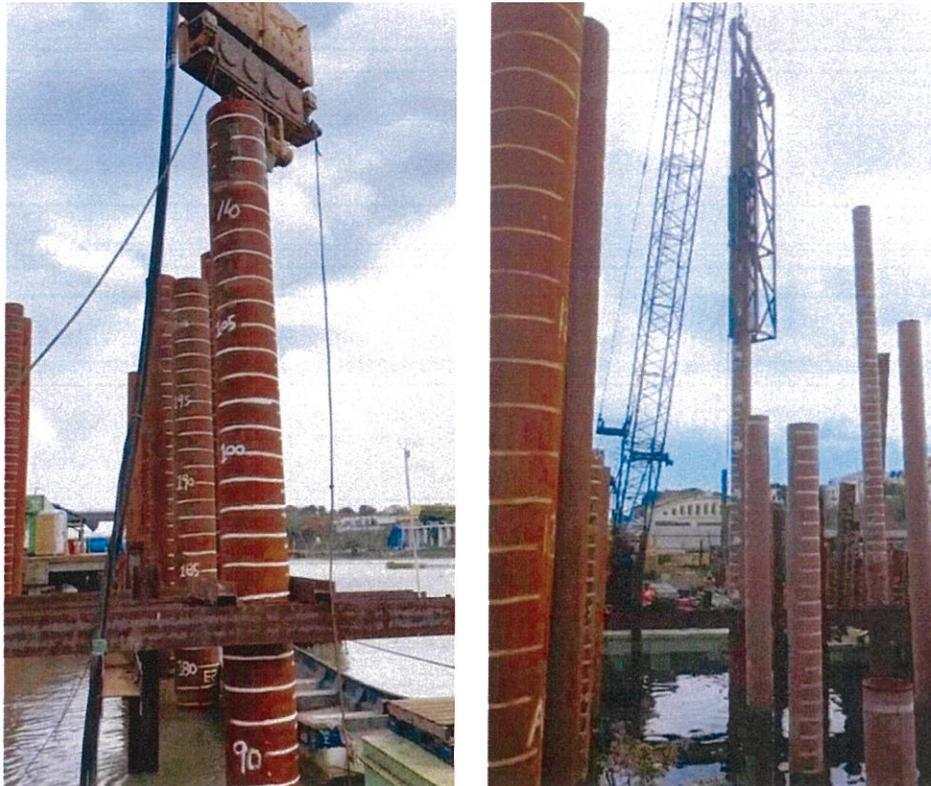
Una vez la camisa ha penetrado en el estrato rocoso, se perforará el pilote por dentro de la camisa, utilizando métodos drill shaft, donde el cubo va cortando cada tramo, extrayendo y botando el material inservible hasta llegar a la profundidad de fundación. En caso de ser necesario el uso de bentonita el oferente deberá considerarlo como parte del proceso constructivo.
