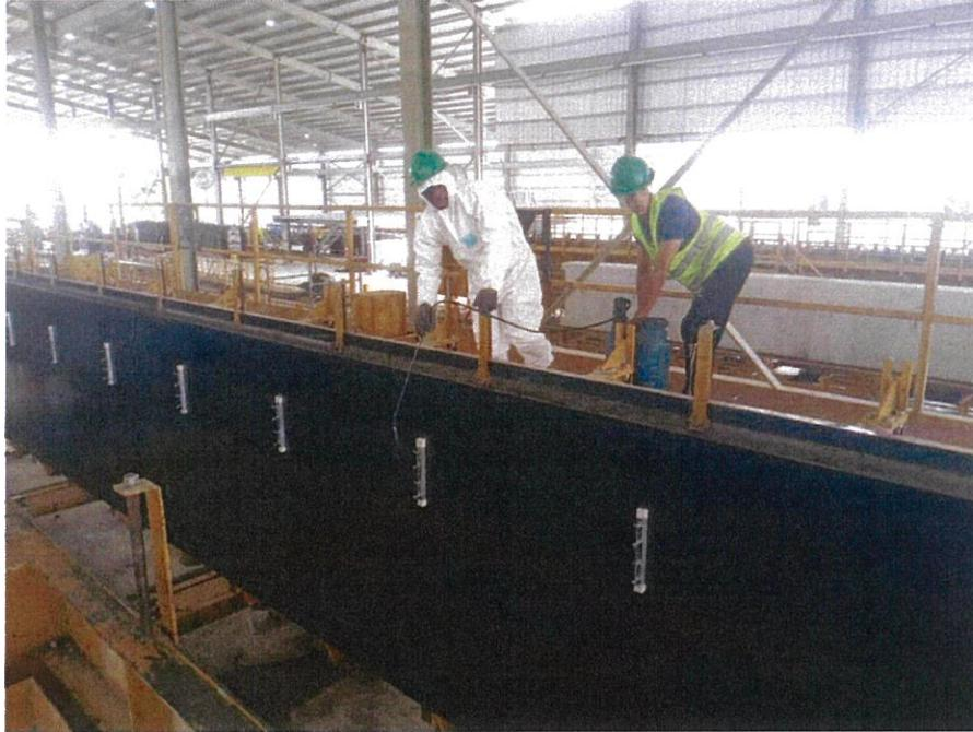
*Ilustración 21. Control Topográfico para Certificación Geométrica de la Viga*
