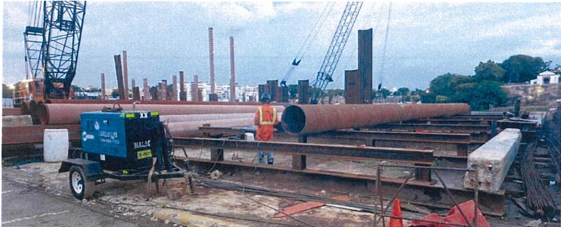
Para el cálculo de los pilotes se deberá considerar un factor de seguridad de 3, el cual podrá reducir hasta 2.5 mediante pruebas dinámicas de la estructura. La carga empleada de manera preliminar es de 130 toneladas por pilote.
