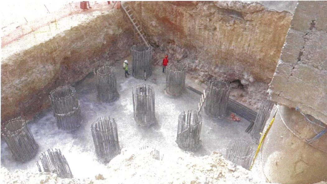
Luego de la perforación y vaciado in-situ de los pilotes, se considerará excavación con retroexcavadora con martillo, compresores de aire y descabezadores de pilotes, que permitan liberar los cabezales de pilotes para el armado del acero de fundación. El acero de fundación reposará sobre un hormigón de limpieza y nivelación de 20 centímetros de espesor, con hormigón 180 kg/cm<sup>2</sup>.
